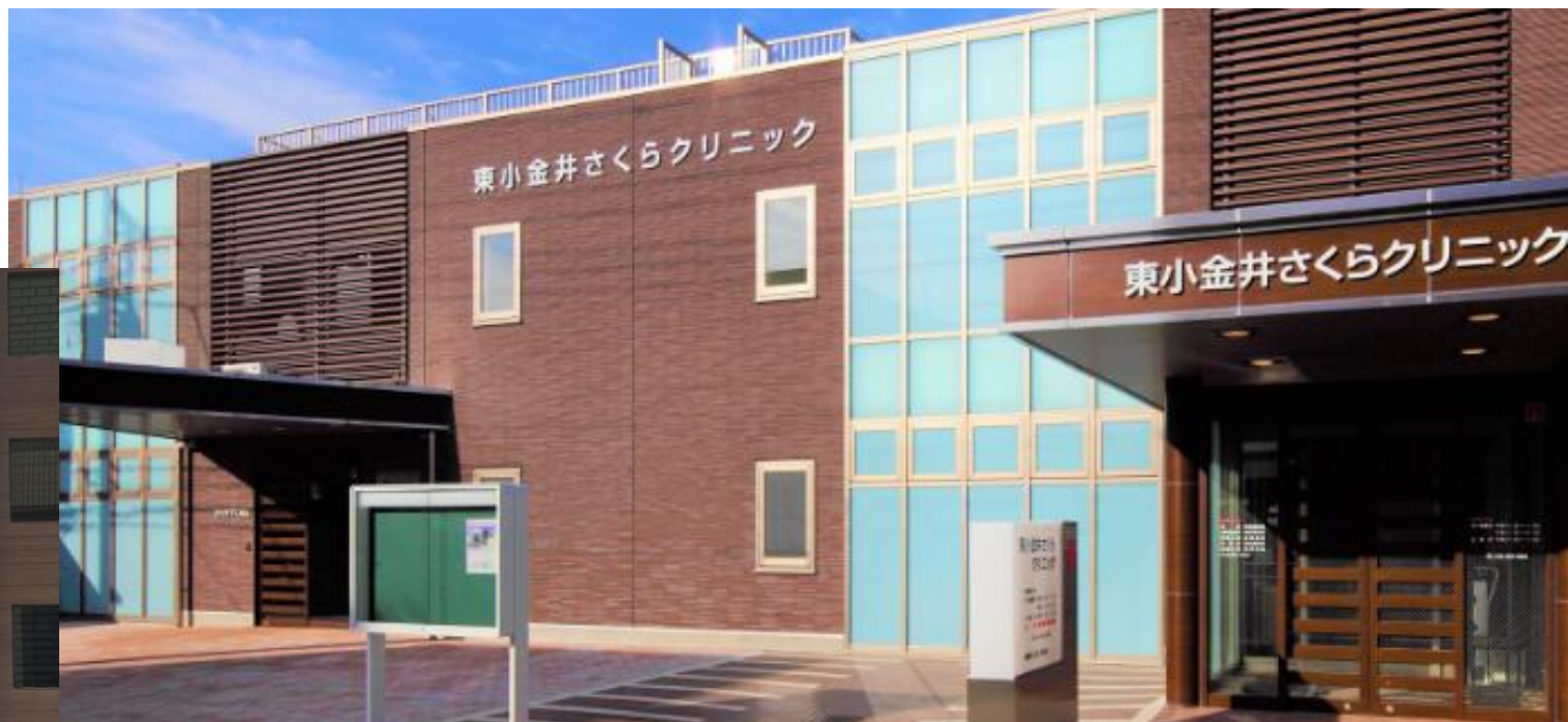
【東小金井さくらクリニック外観】
